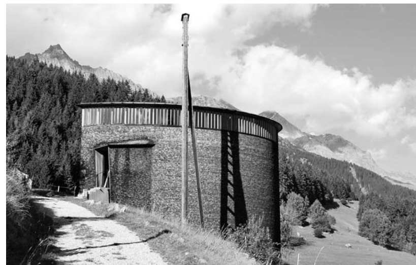
▲ Figura I.3. Peter Zumthor, chiesa di S. Benedict, Sumvitg, 1988. Vista esterna
