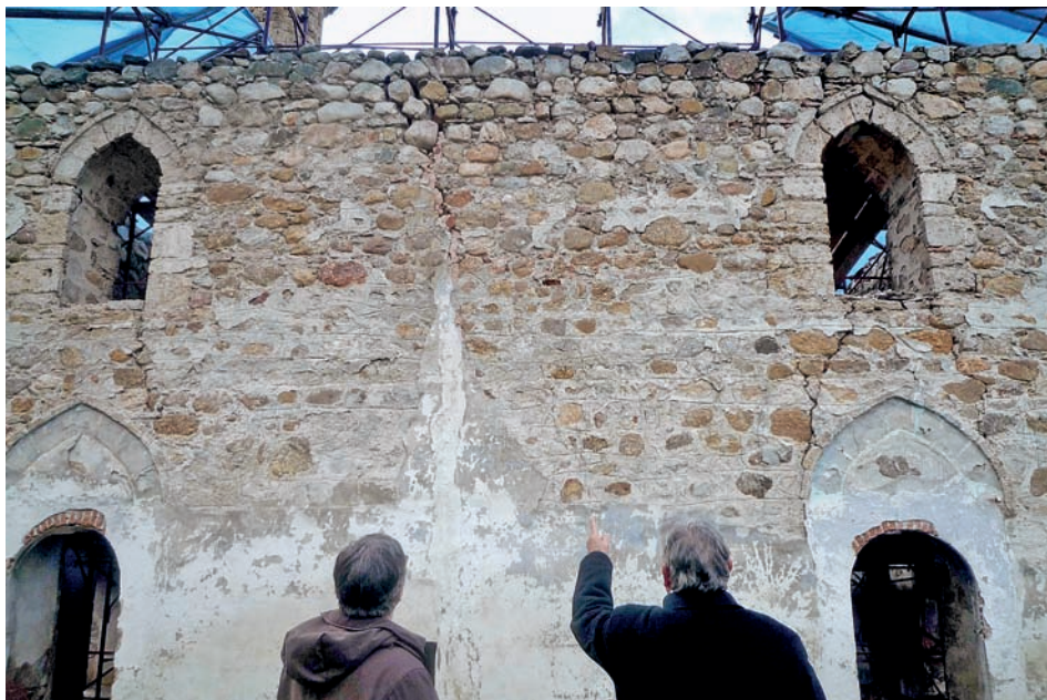
Figura 1.28. Esame delle lesioni della muratura della moschea (fonte: Elvane Islami)
