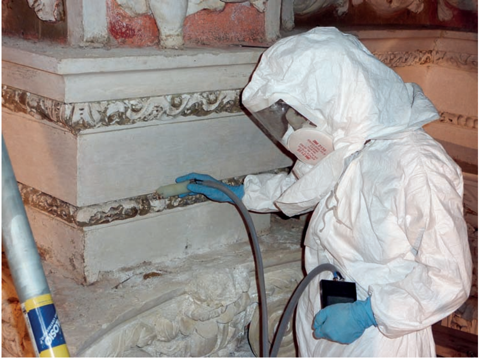
Figura 1.9. Una fase del restauro dei sottoarchi della volta
