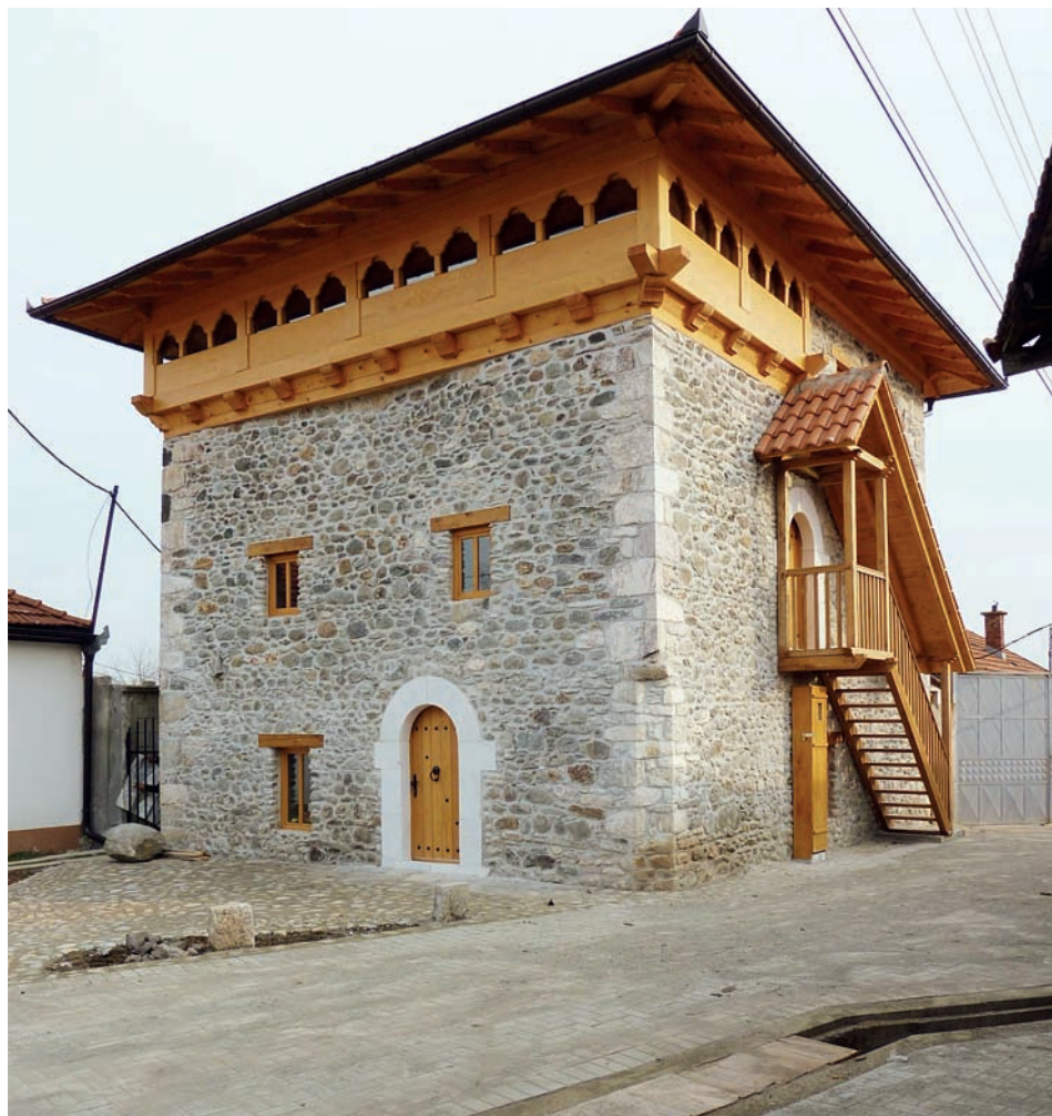
Figura 1.22. La kulla dopo i lavori di restauro e ricostruzione
