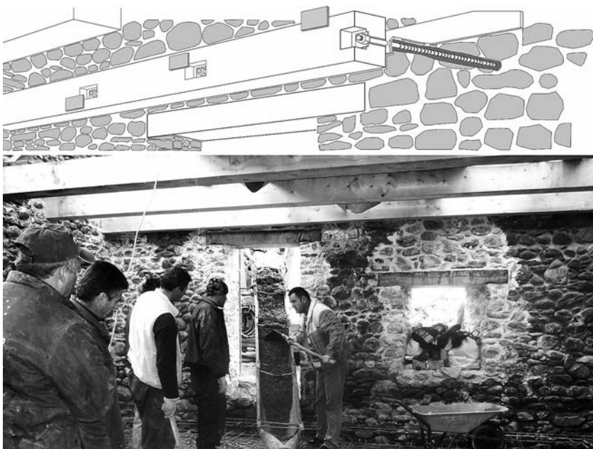
Figura 1.18. Procedura per il consolidamento del vecchio muro rivolto a ovest e posa in aderenza della prima trave del solaio
