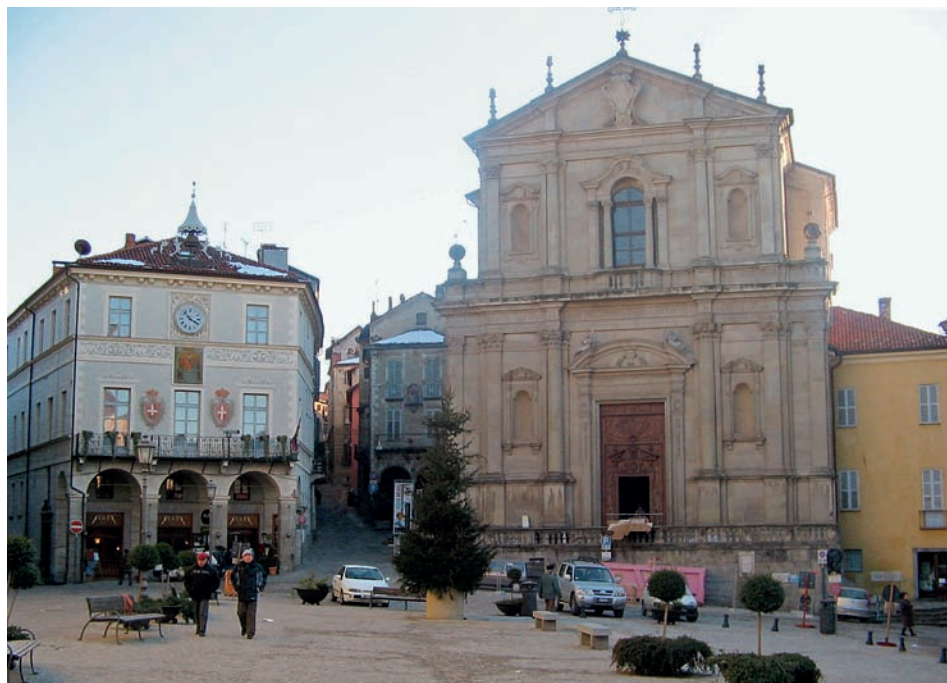
Figura 1.3. Facciata della Chiesa della Missione e Palazzo di Città su piazza Maggiore
