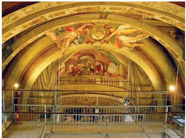
Figura 1.10 Volta della Chiesa a restauro completato vista dal ponteggio. Il percorso di visita creato ha consentito al pubblico la vista ravvicinata dell'opera del Pozzo
