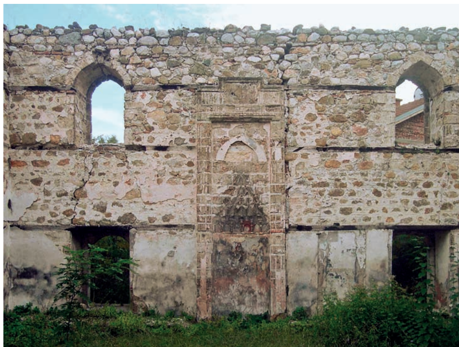
Figura 1.26. Moschea Defterdar di Pejë/Peć: la parete del mihrab alla fine dell'estate del 2008, poco prima dell'avvio del cantiere di restauro
