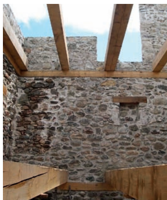
Figura 1.21. Il sistema costruttivo tradizionale delle kulle prevede molti componenti in legno, anche immersi nella muratura
