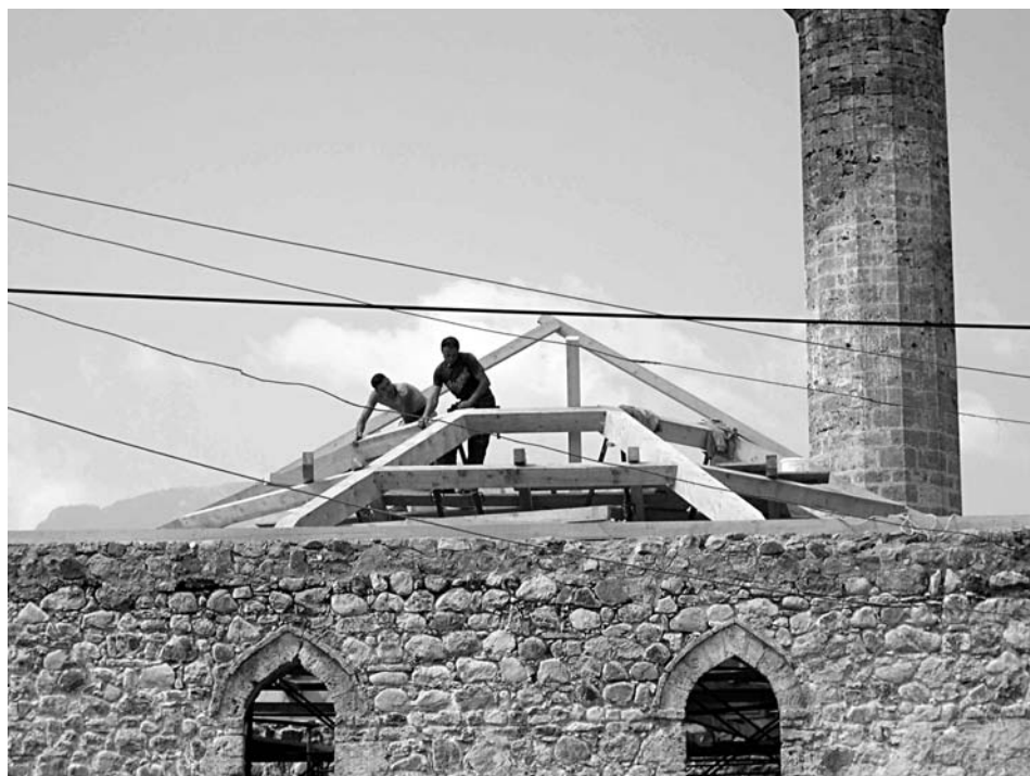
Figura 1.31. Una fase della costruzione della struttura del tetto (fonte: Elvane Islami)
