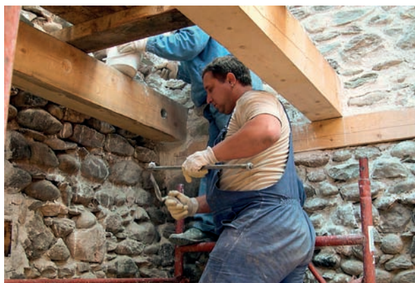
Figura 1.21. Il sistema costruttivo tradizionale delle kulle prevede molti componenti in legno, anche immersi nella muratura
