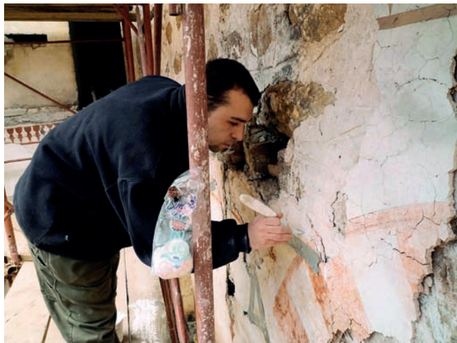
Figura 1.27 Lavori di pre-consolidamento dei resti di intonaco marmorino prima della sospensione dei lavori a causa della stagione invernale (dicembre 2008)
