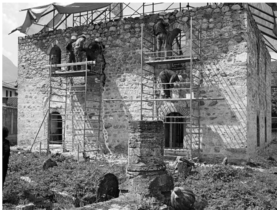
Figura 1.29. Attività di consolidamento della muratura: pulizia delle lesioni e sostituzione di un elemento della struttura di travi di castagno collocata nella muratura su quattro livelli (fonte: Elvane Islami)
