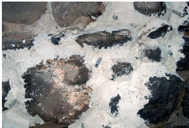
Figura 1.19 Il vecchio muro della kulla è stato preventivamente consolidato mediante iniezioni di calce e pozzolana, secondo la mappatura del degrado eseguita in fase progettuale. Qui la disposizione delle stuccature provvisorie e delle cannule di drenaggio
