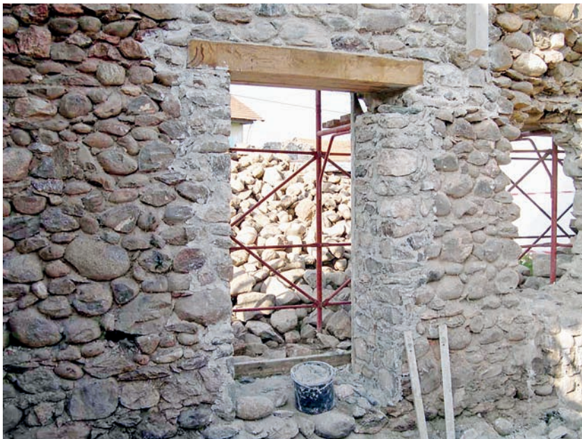
Figura 1.17. Fasi della ricostruzione del foro per la porta di accesso da ovest (II fase)
