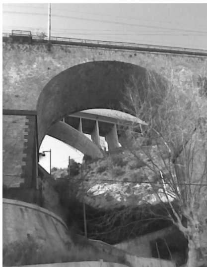
Fig. 5. Circa 50 anni separano il ponte ferroviario in muratura dal ponte autostradale in c.a. realizzato nel 1960 circa (Salerno, foto di P. Lenza)
