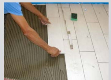
Posa della pavimentazione ceramica a finire
