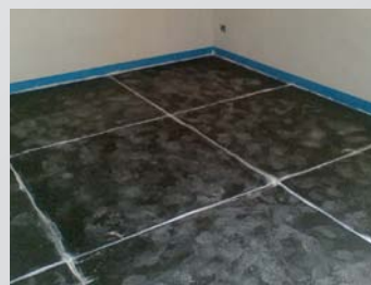
Materassino dBred posato in maniera continua
