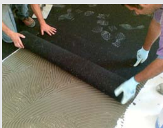
Posa della colla e del materassino dBred
