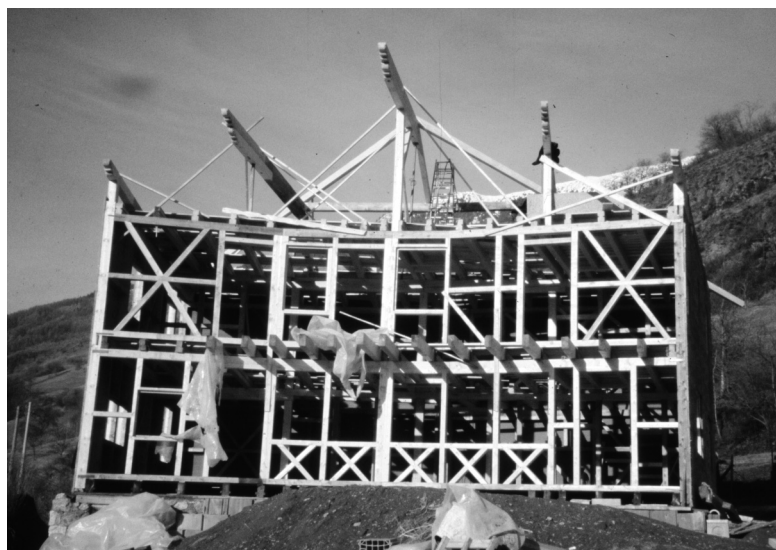
Fig. 6.1 L'immagine mostra le strutture portanti di un edificio in legno realizzato in Trentino Alto Adige. La facciata dell'edificio è stata studiata in modo da ricevere al meglio la radiazione solare. Foto tratta da un cantiere dell'azienda Jörg Klimahaus GmbH/Srl.
