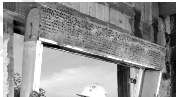
Fig. 6.5 Immagine tratta dalla brochure della ditta Roverplastik S.p.a. ( www.roverplastik.it ). La ditta produce i cassonetti isolati per avvolgibili "Kingsystem" costituiti da argilla espansa legata da poliuretano che hanno trasmittanza U = 0,80 - 0,30 \text{ W/m}^2\text{K} . Nella figura si può notare l'elemento "RoverBlock" con spalle e sottobancale in schiuma rigida di poliuretano a celle chiuse per isolare il giunto tra muro e infisso.
