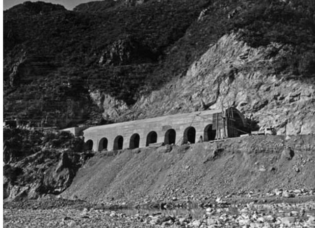
Fig. 1.2 Galleria artificiale paramassi.
