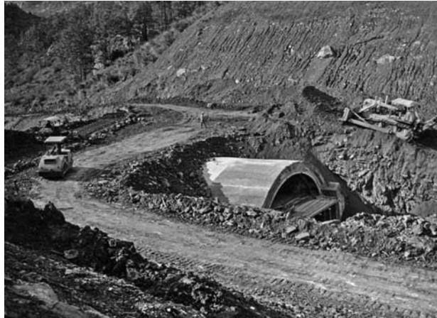
Fig. 1.3 Interramento galleria artificiale.
