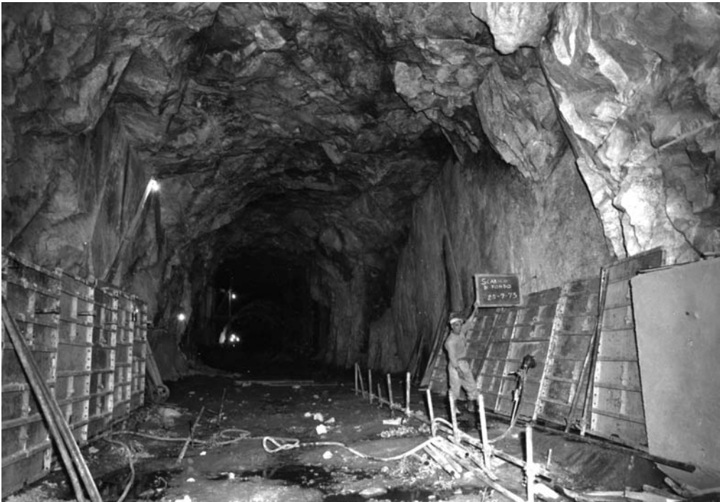
Fig. 1.8 Galleria scarico di fondo – diga di Pattada.
