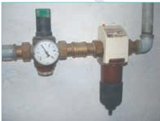
Figura 2: Filtro e riduttore di pressione
