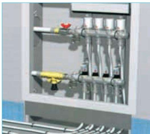
Figura 4: Cassetta di distribuzione con regolazione termostatica
