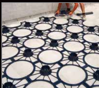
fig.1) posa della Base Nuovo Elevetor®
