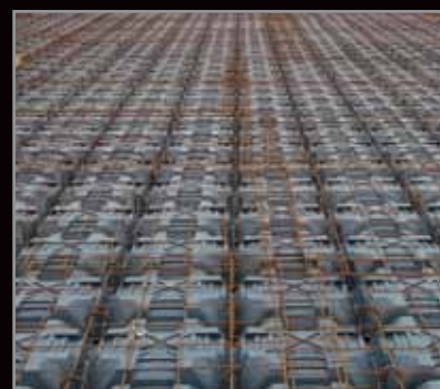
fig.6) posa della rete elettrosaldata
