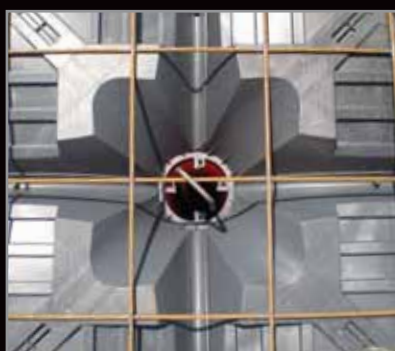
fig.7) armatura dei pilastrini con forcilla
