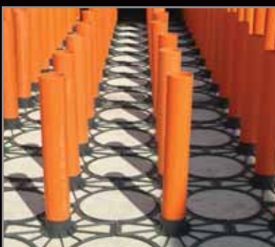
fig.2) posa dei Tubi
