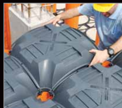
fig.3) posa dei Casseri Nuovo Elevetor
