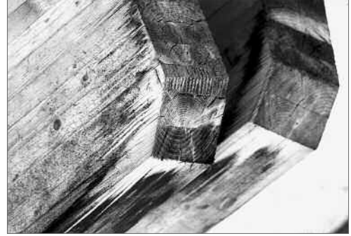
Fig. 1.5. Queste teste di travi lamellari sono interessate da batteri, funghi dell'azzurramento ed altri cromogeni. Ancora non c'è perdita delle capacità meccaniche, ma non tarderanno ad insediarsi altri funghi che porteranno al marcimento della testa.
