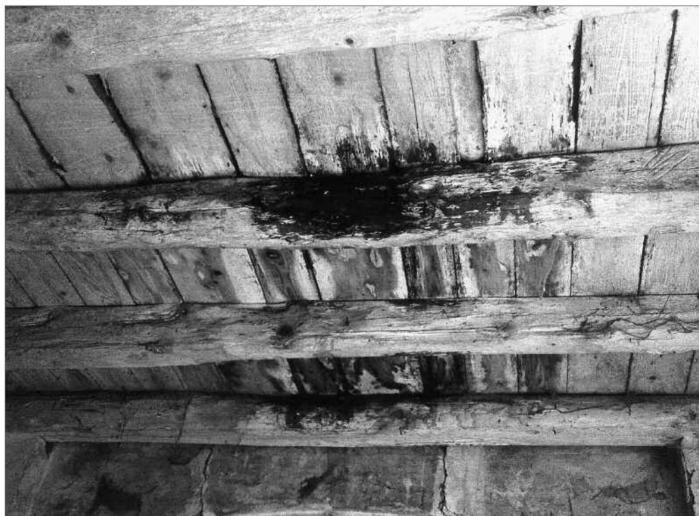
Fig. 1.4. Le alterazioni cromatiche sono indice di presenza di funghi, ovvero di infiltrazioni d'acqua.
