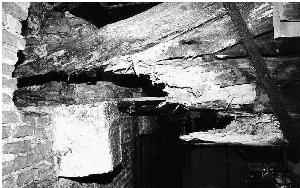
Fig. 1.7. Distruzione del legno da parte dei funghi del marcimento. La struttura si regge perché sostenuta da elementi trasversali, non inquadrati.
