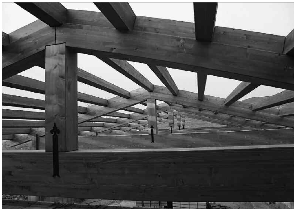
Figura 2. Il giudizio sullo stato di una struttura lignea consegue non solo ad indagini sulla consistenza materica, ma presume anche la conoscenza della sua concezione strutturale. Perciò una buona diagnosi è sintesi di competenze diverse, sia sul legno, sia sui comportamenti strutturali. Ad esempio non sarebbe possibile intervenire su questa struttura se prima non si riconoscesse che non siamo al cospetto di una capriata, bensì di una trave semplicemente appoggiata!
