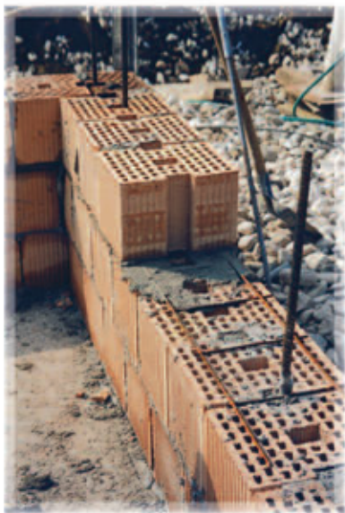
A sinistra: particolare della realizzazione della Muratura Armata POROTON®. Le barre verticali sporgenti (opportunamente ancorate e sovrapposte) permettono la trasmissione delle sollecitazioni lungo tutta l'altezza dell'edificio
