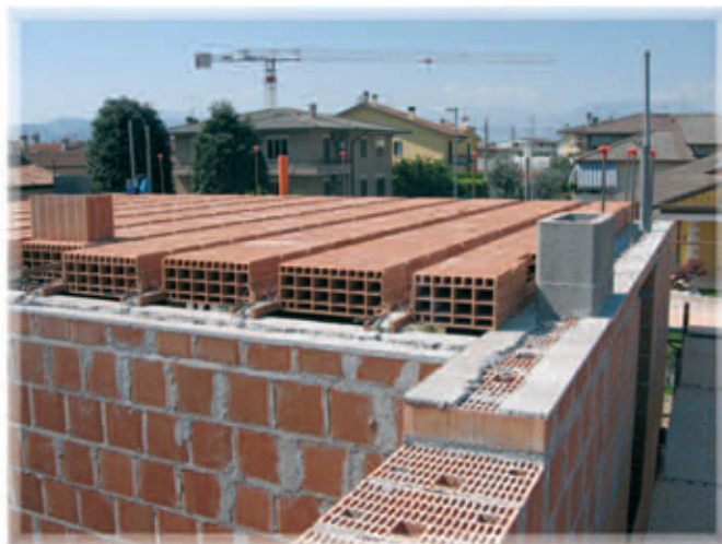
In alto: realizzazione del solaio sulla struttura in Muratura Armata POROTON®
