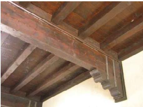
Solaio a doppia orditura visto da sotto: si vedono i travi principali ed i travetti secondari orditi trasversalmente.
