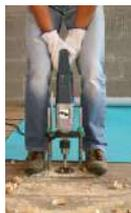
Trapano a coppia elevata montato, su un supporto stabile; permette di eseguire grossi fori sull'assito per alloggiare i connettori "BASE" in piena sicurezza per l'operatore.
