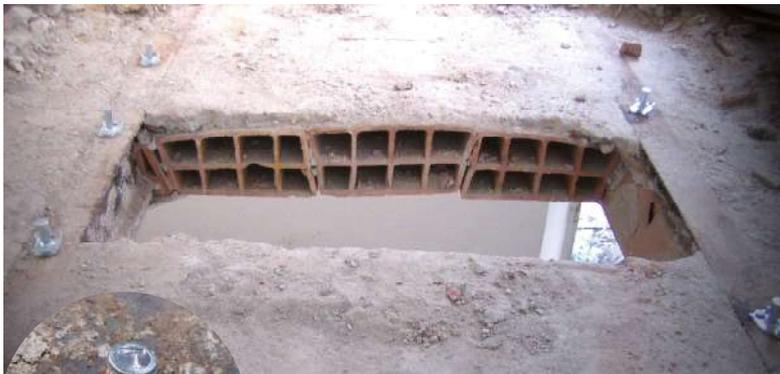
La composizione chimica delle putrelle in ferro esistenti rende difficoltosa, se non impossibile, la saldatura di elementi metallici, ostacolata anche dalla presenza di polvere, ossidazioni o malta: il fissaggio a freddo con connettori TECNARIA risolve efficacemente il problema poiché i chiodi penetrano direttamente nell'acciaio. La semplicità nella posa in opera rende il sistema ideale per questo impiego!
