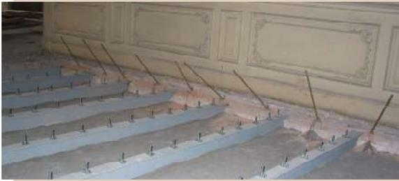
In alternativa ai solai in legno, a partire dalla seconda metà dell'Ottocento, si realizzavano di frequente solai con travi in ferro a doppio "T" con interposti elementi in laterizio. Le putrelle poggiavano sui muri maestri ad interassi normalmente variabili dai 60 ai 110 cm ed erano intervallate con elementi in laterizio pieno o forato.
