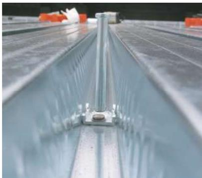
Il connettore è costituito da un piolo con testa, inserito in una piastra di base sulla quale si fissano due chiodi. Date le sue dimensioni l'impiego prevalente è per solai non sollecitati in maniera rilevante, per restauri e in generale ove è richiesta grande flessibilità di utilizzo.
