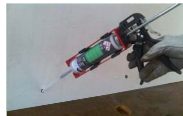
Installazione con pistola manuale
